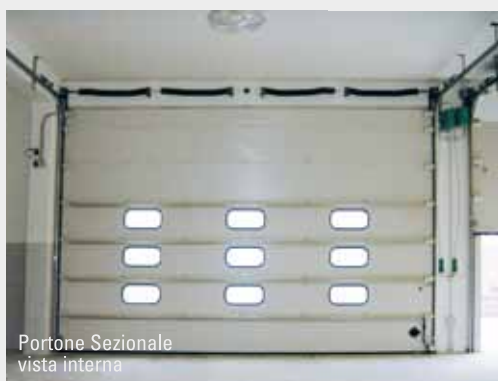
Motorizzazione trifase laterale con catena (uso industriale)
